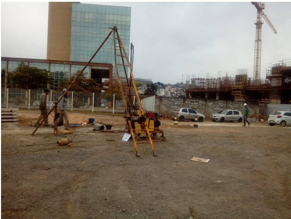
Instalação do furo SM-04
