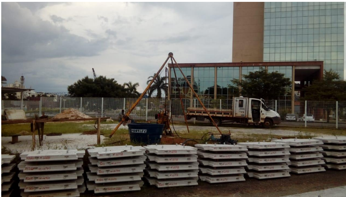
Instalação do furo SM-01
